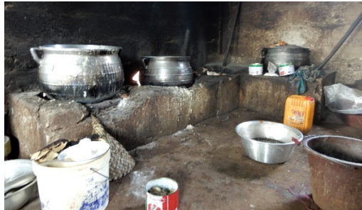
Rénovation de cette cuisine
