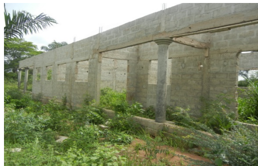
1 des 8 logements des malades en construction (mars 2015)
