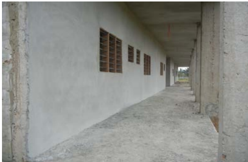
(sous la terrasse d'entrée)
